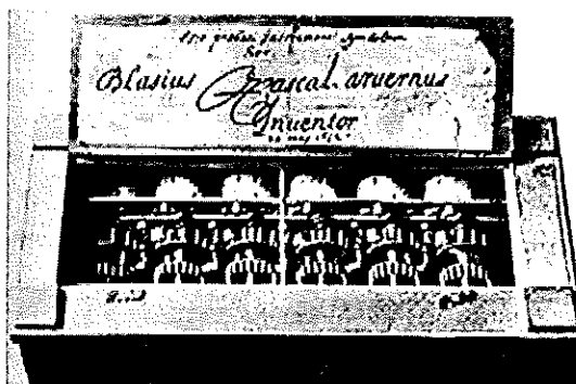
La machine arithmétique de Pascal
